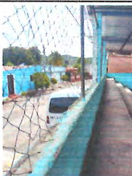
Foto 3: Sustitución malla de acero galvanizado en perímetro del establecimiento, con instalación fija y tensa, anclajes metálicos en intervalos regulares
