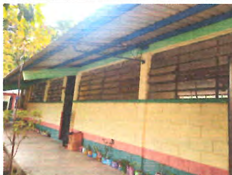
Foto 4: Sustitución de ventanas; sistema de apertura: Corredizas, Perfiles color blanco estandar, Material del marco: PVC Material de la ventana: Vidrio, sellado perimetral en módulo de aula.
