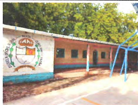
Foto 2: Preparación de la superficie y aplicación de pintura a dos manos, en paredes exteriores del establecimiento.
