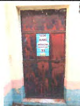
Foto 6: Mantenimiento a puerta metálica existente retiro de óxido, suciedad y pintura deteriorada; incluye cepillado, lijado y aplicación de pintura
