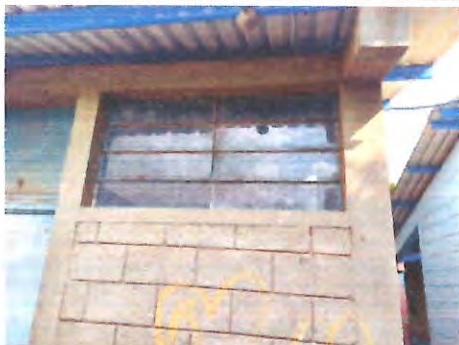
Foto 1: Sustitución de ventanas; sistema de apertura: Corredizas, Perfiles color blanco estandar, Material del marco: PVC Material de la ventana: Vidrio, sellado perimetral en área de cocina.
